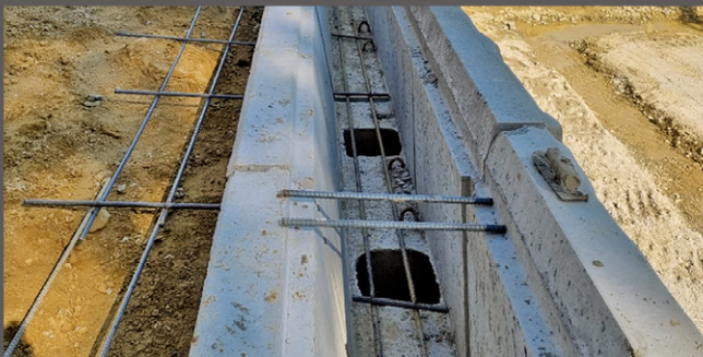
7) 상단(배수, L형)블록 설치 - 블록 내부 및 천단에 철근 배근 - 기동체 철근 기초블록까지 연결
