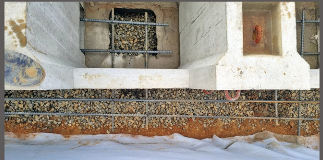
4) 철근 배근 및 콘크리트 타설 - 좌우블록 및 지반과 일체화 기초블록 내부에 철근 격자 배근 후 콘크리트 타설
