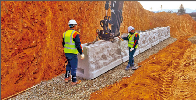
3) 기초블록 설치 - 약 6M마다 기초기동체블록 설치(현장 여건별 간격조정) 내부에 THP 이중벽관 설치 후 콘크리트 타설
